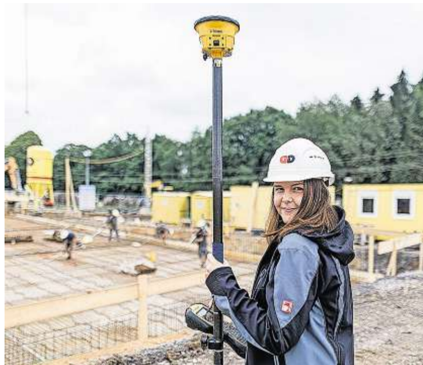
Die Absteckung mittels eines GPS-Rovers
