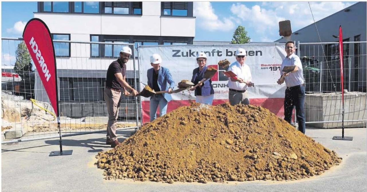
Spatenstich für den Erweiterungsbau des ACI-Gebäudes: Die Firma Horsch investiert zwei Millionen Euro in die „Ideenwerkstatt“.
