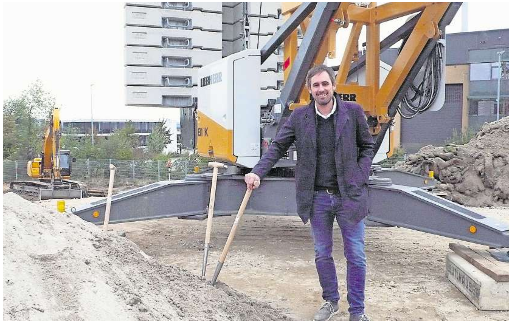
Der Mann packt an – und den Mann bringt nichts aus der Ruhe: Matthias Altmann errichtet am Bierlacker seinen Firmenneubau.
