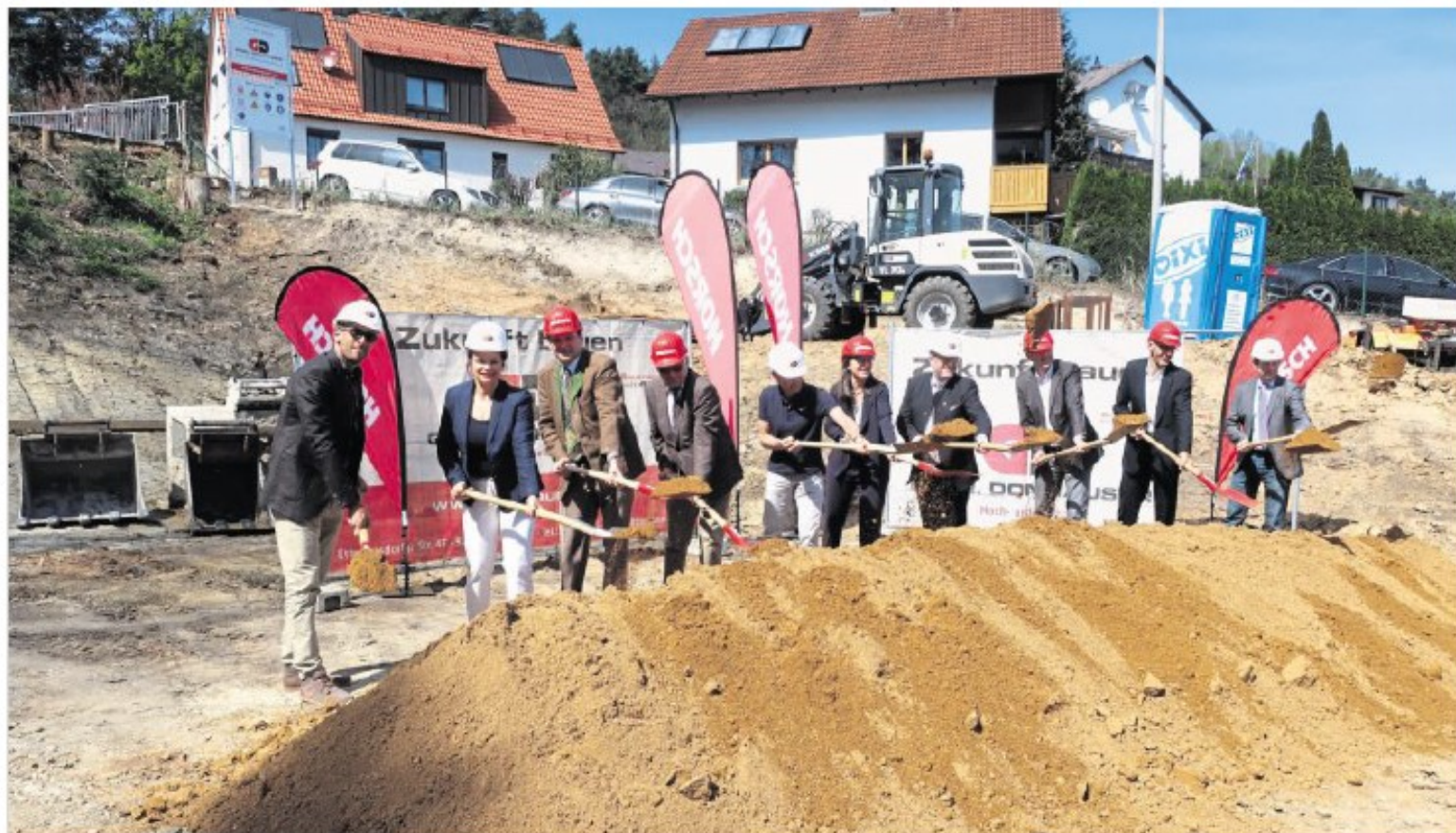
Spatenstich für ein Zwei-Millionen-Projekt am Ettmannsdorfer Berg: Hier entstehen Boardinghäuser mit insgesamt 27 Betten für Mitarbeiter der Firma Horsch.
