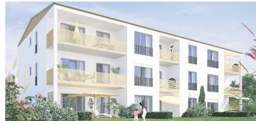
In Pentling baut Donhauser eine Wohnanlage mit 75 Eigentumswohnungen.
