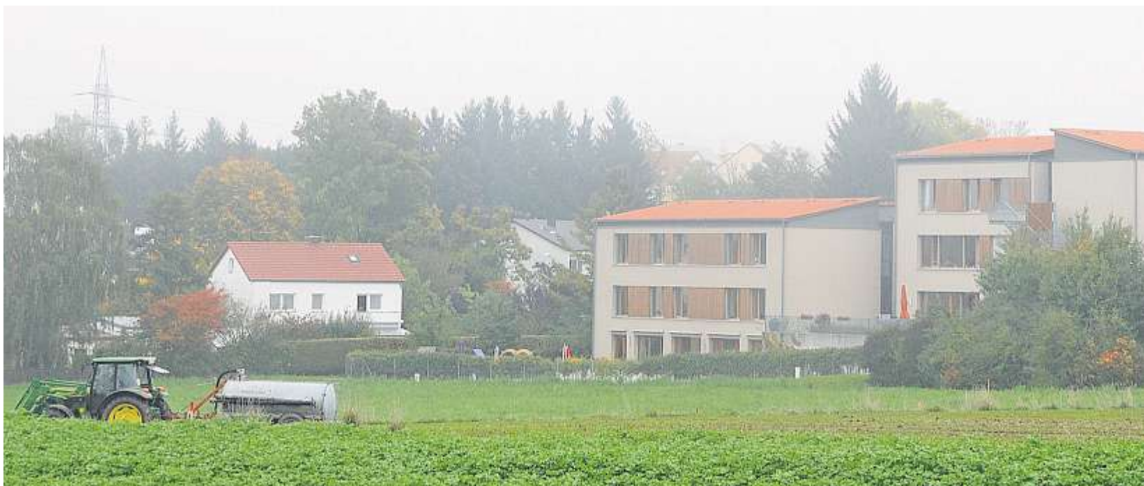
Noch ist hier eine landwirtschaftliche Fläche, in Zukunft wird hier gebaut.
